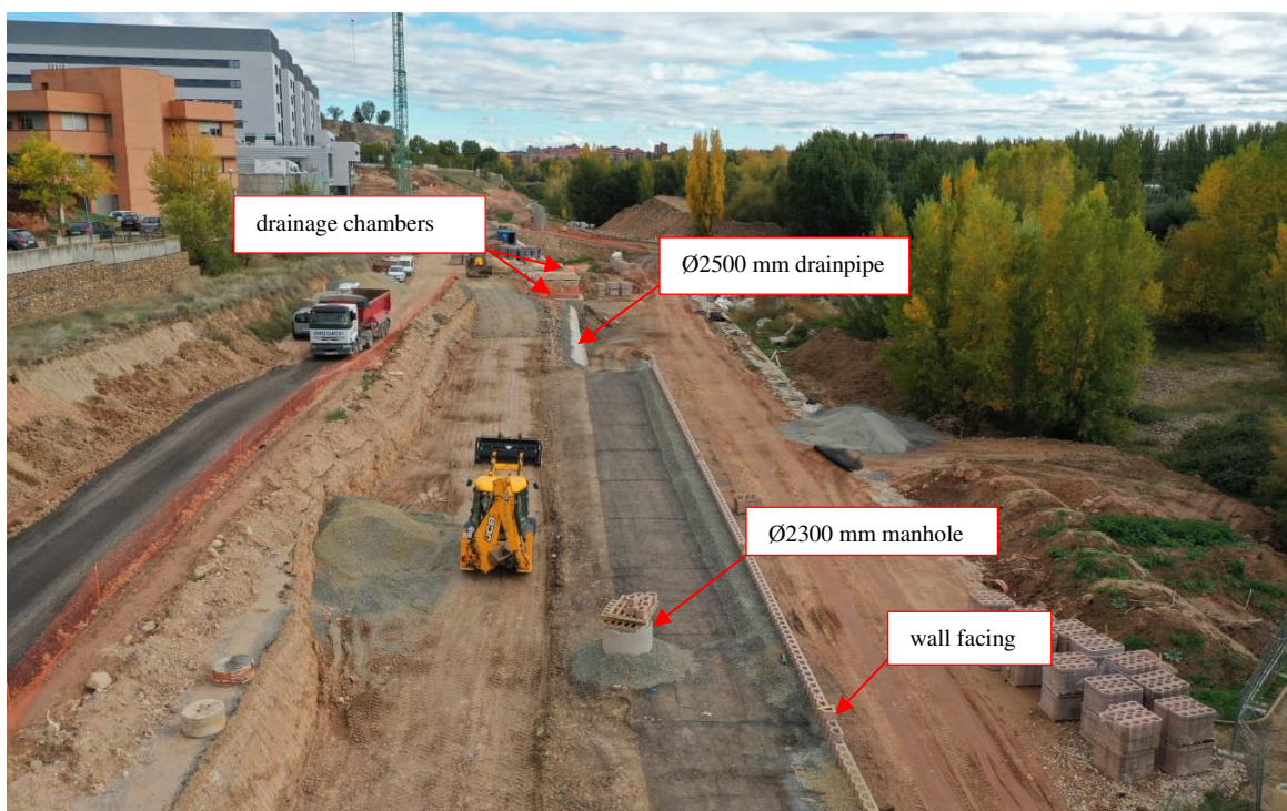
Figure 3. Wall 1 under construction (Orbe Técnicas y Medioambiente).
