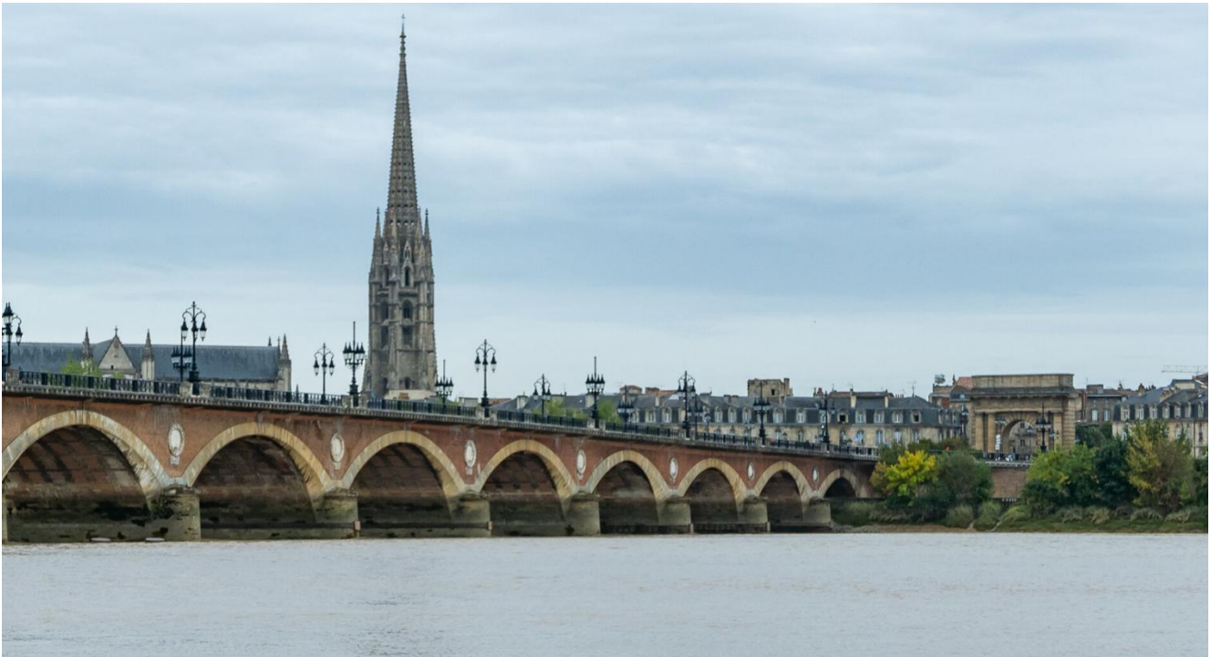
Figure 1. The Pont de Pierre of Bordeaux.
