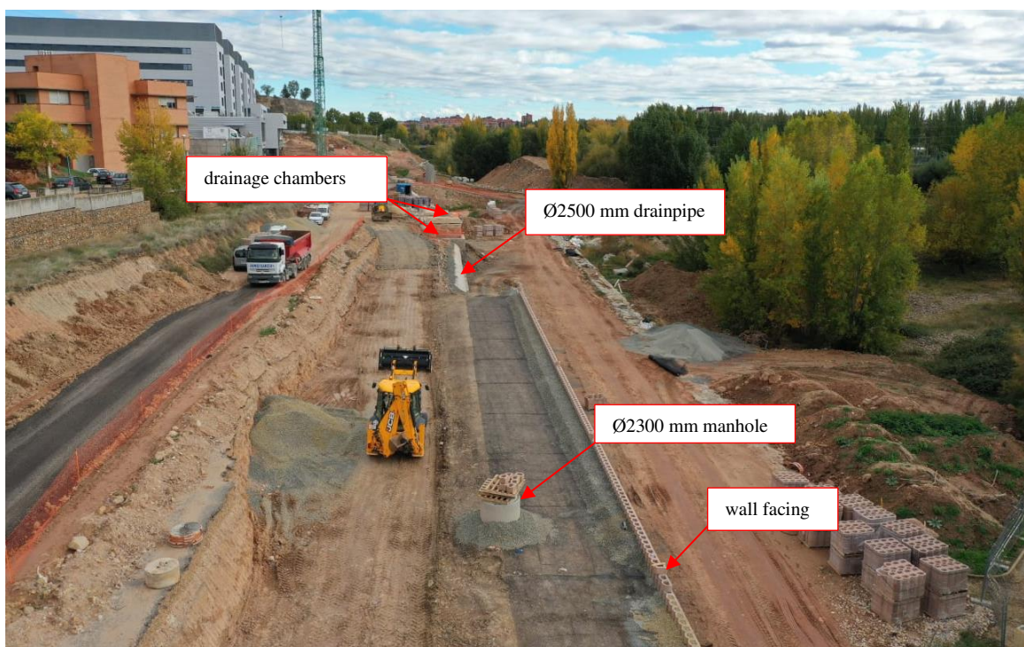
Figure 3. Wall 1 under construction (Orbe Técnicas y Medioambiente).
