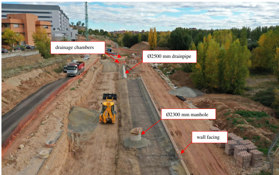
Figure 3. Wall 1 under construction (Orbe Técnicas y Medioambiente).
